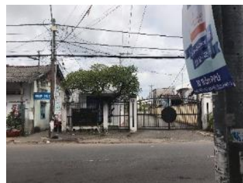
Nhà máy nước Rạch Giá Công suất 50.000m 3 /ngđ
