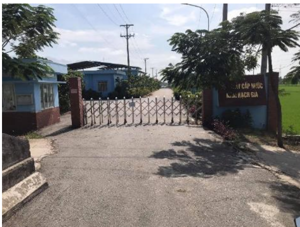
Nhà máy nước Nam Rạch Giá Công suất 20.000m 3 /ngđ
