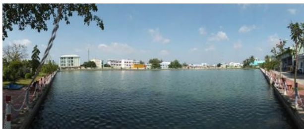
Hồ chứa nước thô (của nhà máy nước Rạch Giá)
